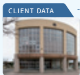
CLIENT DATA 導入学校 / 青森市立荒川中学校 所在地 / 青森県青森市 設立 / 1947年
